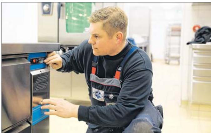
Überprüfung der elektrischen Regeleinheit an einem Kühltisch in einer Grossküche.
