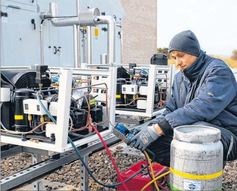
Die Firma Schnoor entwickelt hochwertige und anspruchsvolle Anlagen im Bereich der Kälte- und Klimatechnik: Inbetriebnahme und Befüllung einer Danfoss-Kältemaschine.
