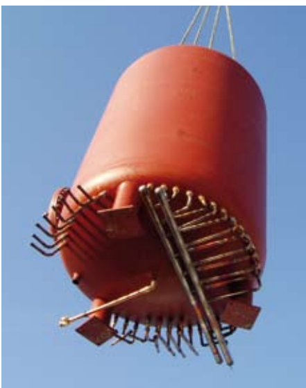
Der Warmwasserspeicher wird mit einem Kran in den Technikraum eingebracht
