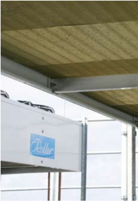
Die Verflüssiger auf dem Dach des Gebäudes sind mit Goldlack beschichteten Lamellen versehen, um gegen Korrosion besonders geschützt zu sein
